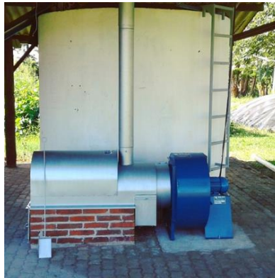
Figura 6. Silo de alvenaria
