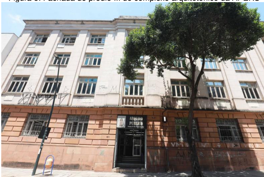
Figura 5: Fachada do prédio III do complexo arquitetônico da APERS
