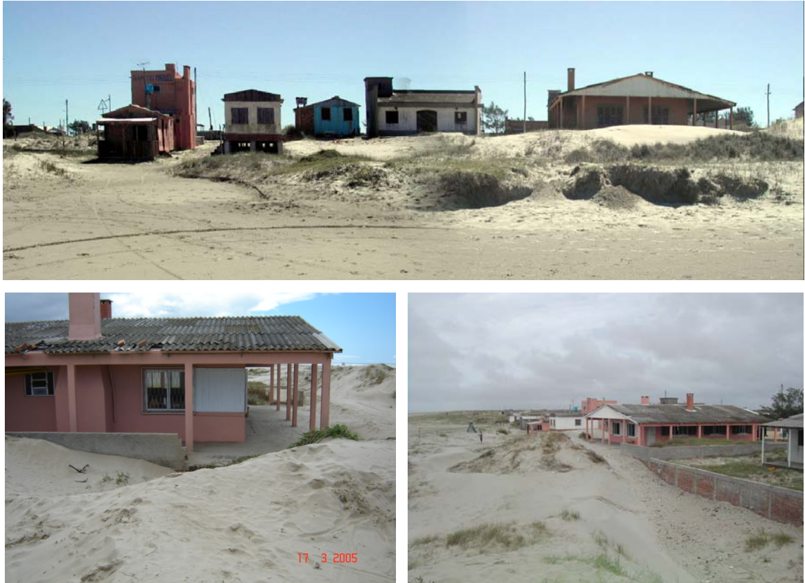
Figura 2.20 – Construções residenciais construídas sobre as dunas e problemas ocasionados pela invasão de areia nas casas.
