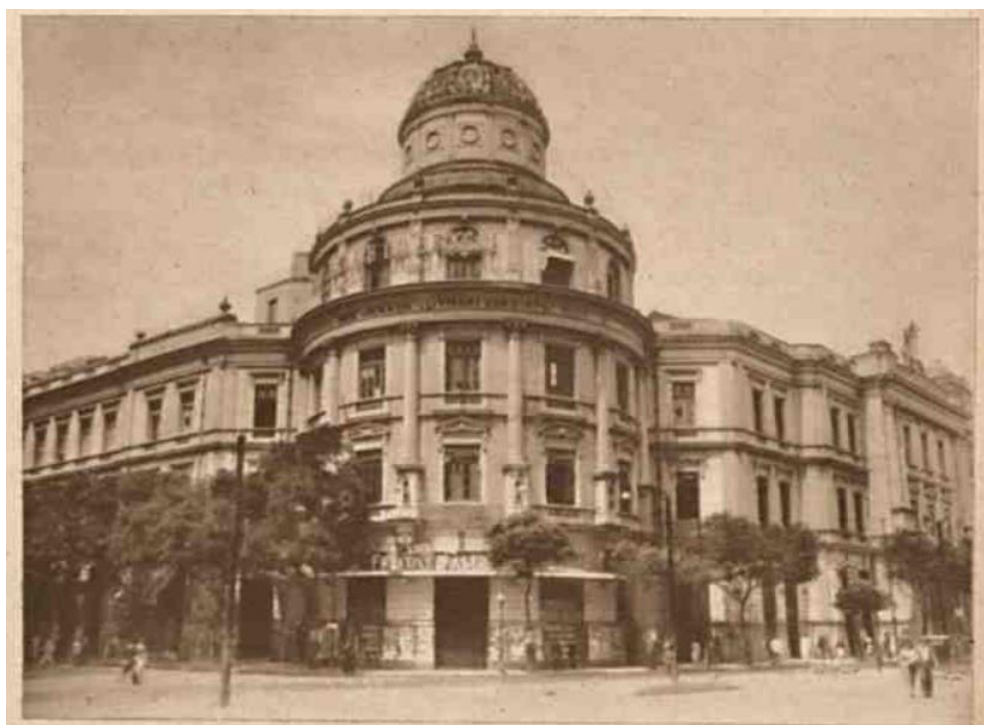
Figura 119 - Fachada da Livraria Freitas Bastos
