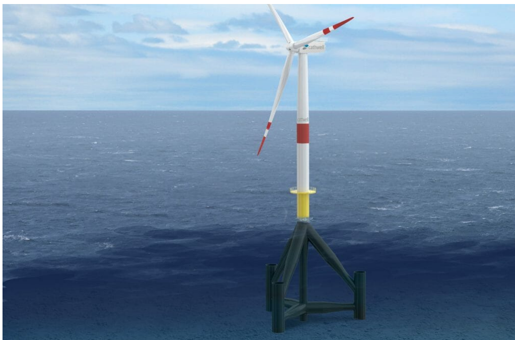
Figura 4.27: Projeto fundação por tripé de turbina eólica offshore . Fonte: CATWELL, 2021.
