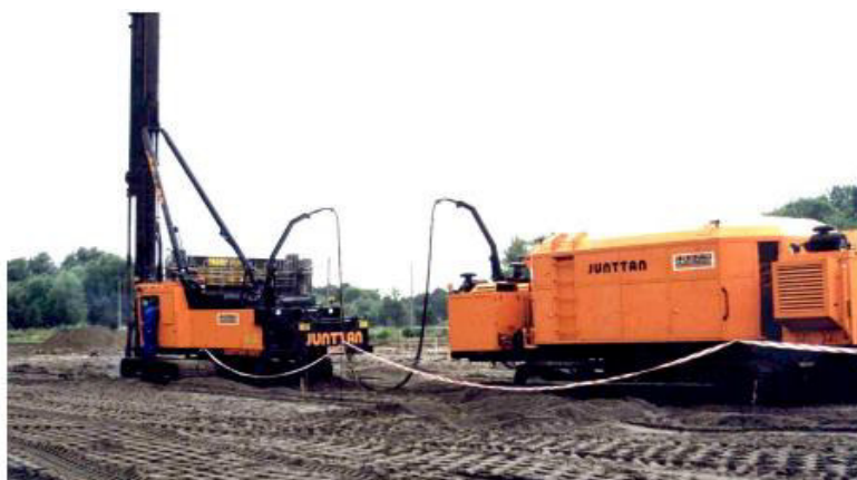
Figura 2.5: Instalação das colunas.
