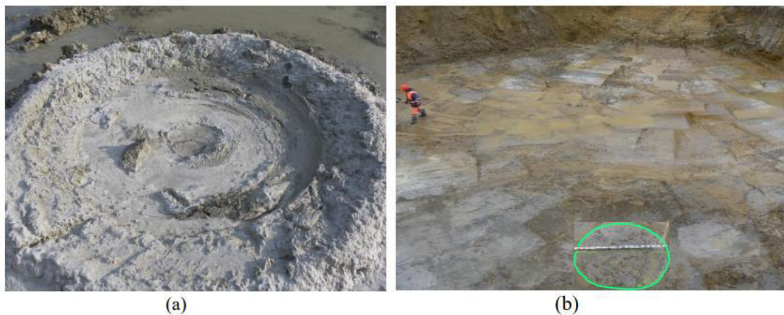
Figura 2.23: Coluna executada para turbina de 119m.
