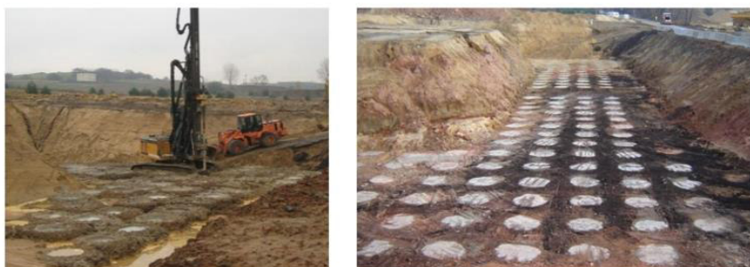
Figura 2.18: Execução de colunas para um aterro rodoviário.
