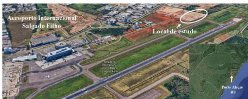
Figura 2.24: Local da Obra em DSM.
