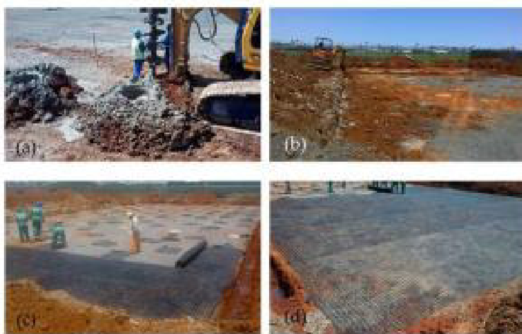
Figura 2.25: Execução das colunas de DSM.
