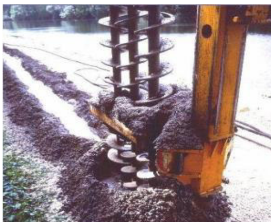
Figura 2.4: Ferramenta de corte utilizando brocas.
