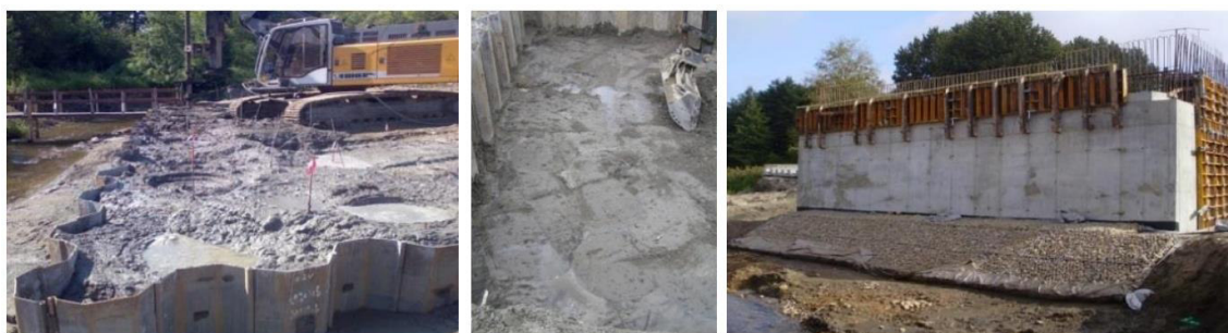
Figura 2.20: Execução das colunas em aterro rodoviário.
