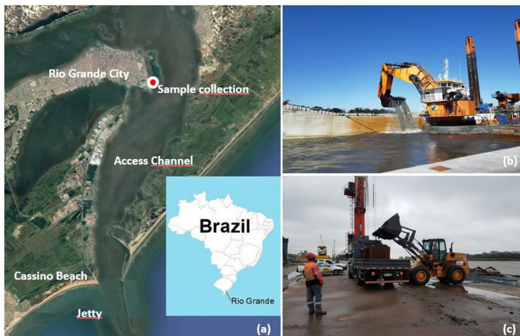
Figura 3.1: Coleta do rejeito de dragagem. (a) Localização do Canal de Acesso, (b) e (c) coleta e disposição em reservatório.
