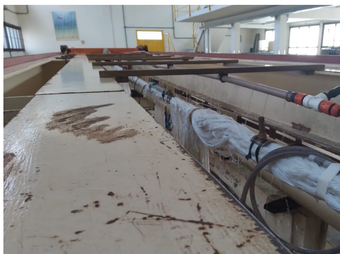
Figura 18 - Instalação do sistema de molhamento.
