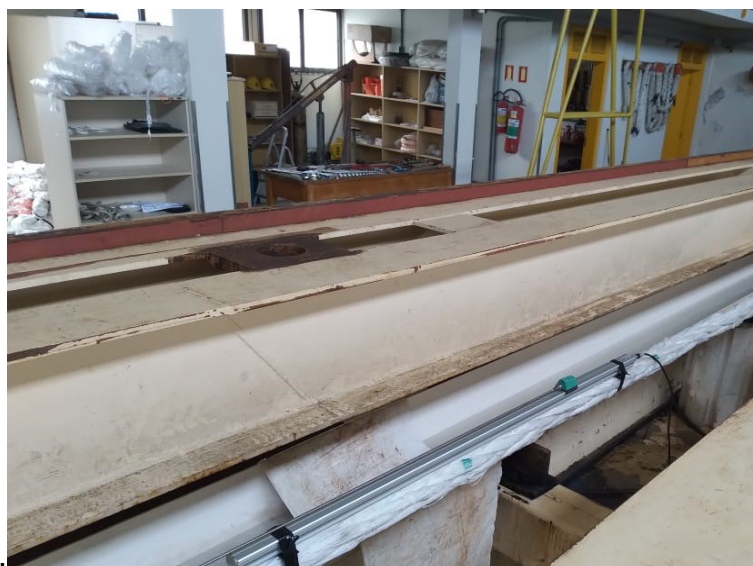
Figura 17 - Instalação dos extensômetros
