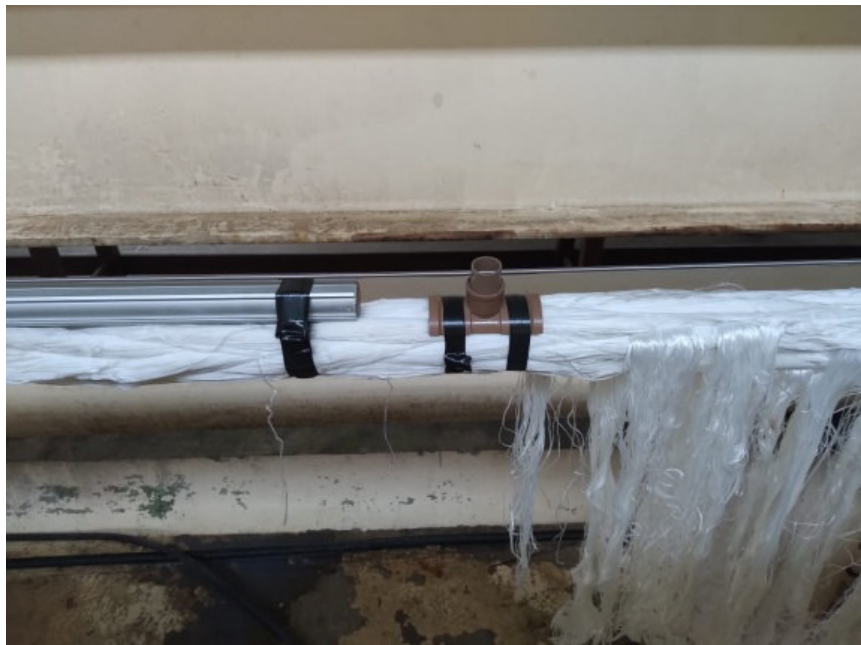
Figura 16 - Fixação distante da construção dos olhais lado cilindro.
