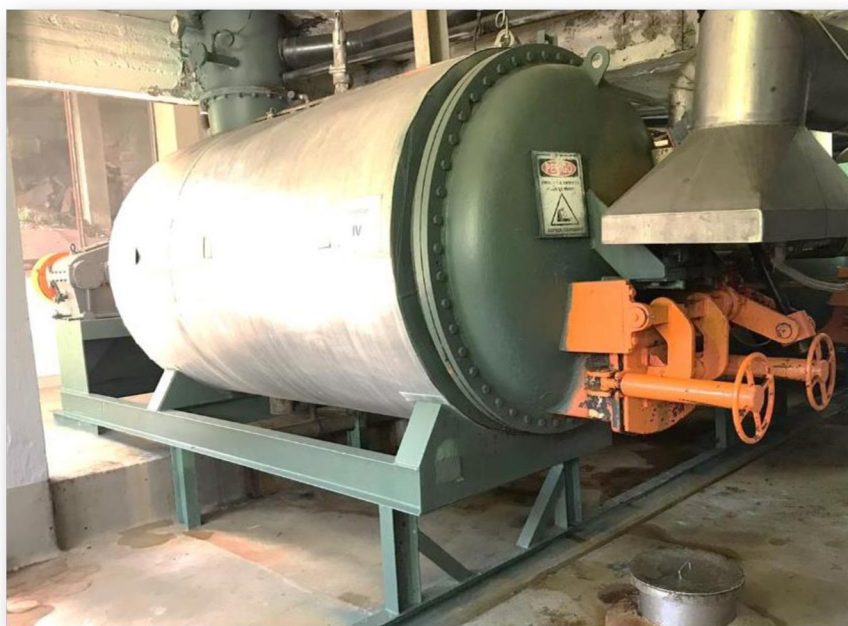
Figura 3 - Digestor de penas
