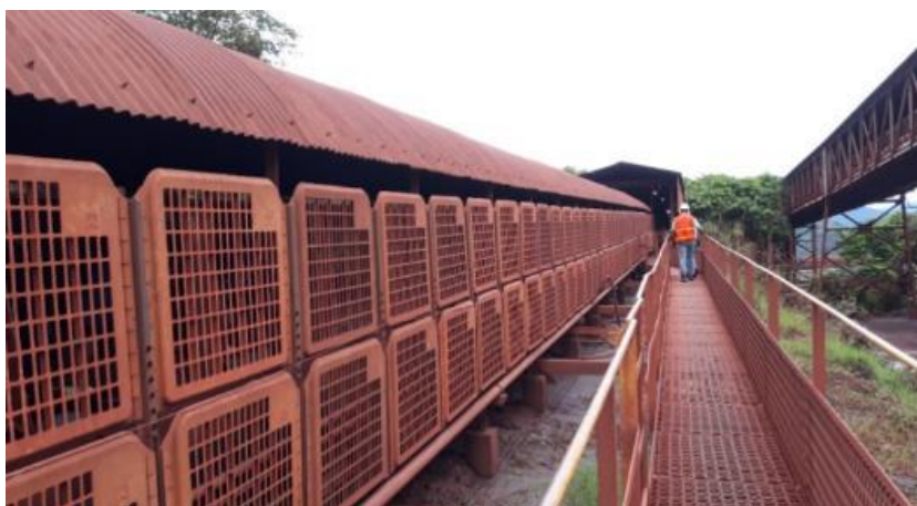
Figura 18 – Passadiço e cobertura de um transportador de correia.
