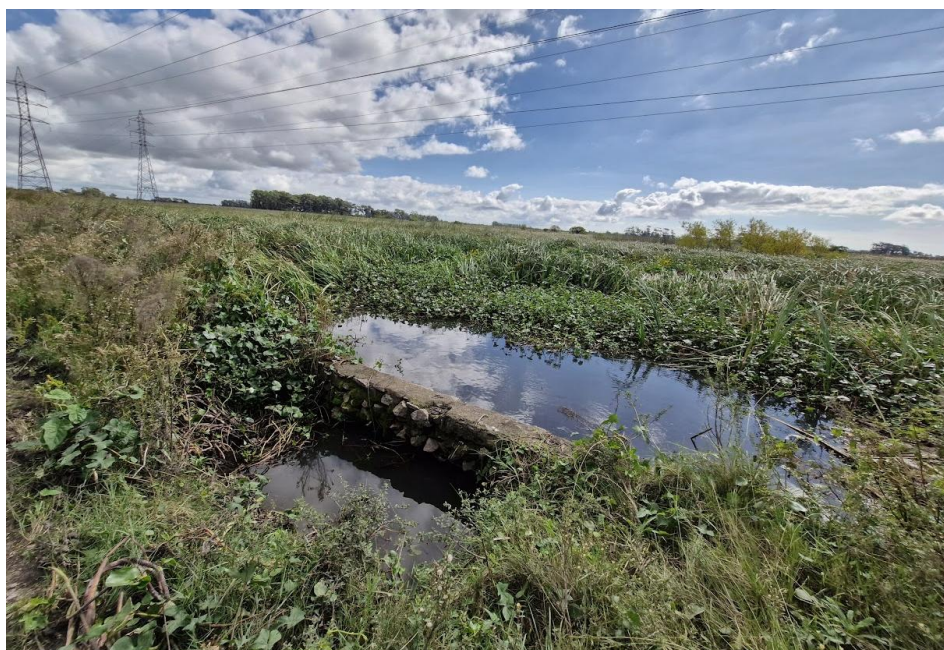
Figura 3.7: Extravasor de pedra da adutora. Fonte: autoria própria (2025).
