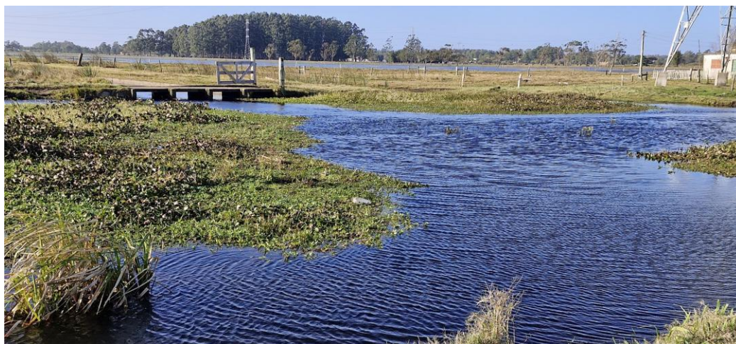
Figura 3.6: Comportas que regulam a entrada de água do Arroio Vieira para a adutora.
