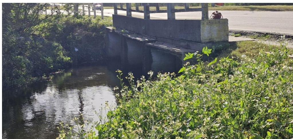
Figura 3.2: Trecho do Arroio Vieira que é atravessado pela ERS 734. Fonte: autoria própria (2025)
