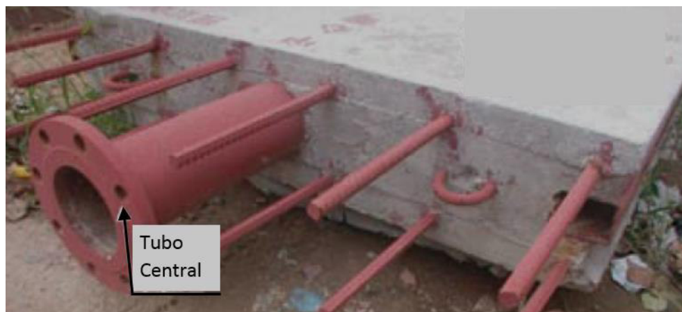
Figura 2.23: Topo das estacas pranchas jateadas e grauteadas – tubulação responsável pela fluidização (Xu et al. , 2014).
