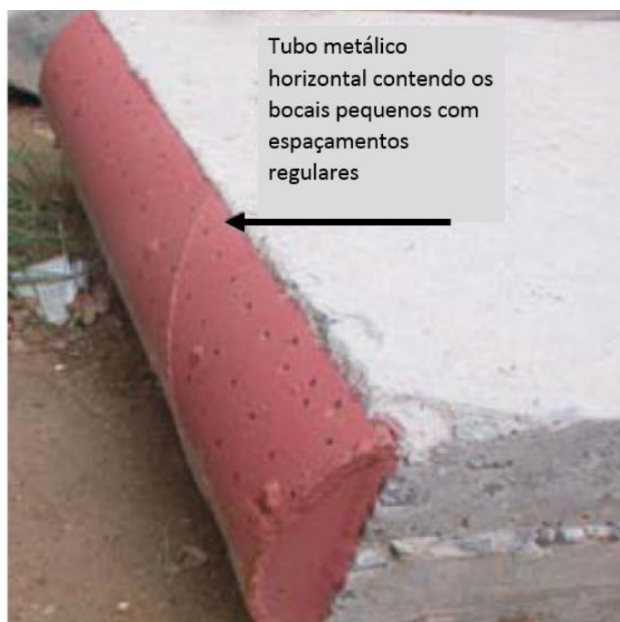
Figura 2.24: Ponta das estacas prancha jateadas e grauteadas - tubulação responsável pela fluidização (Xu et al. , 2014).
