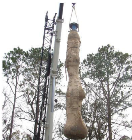
Figura 2.21: Estaca Jetted and Grouted Precast Pile (JGPP) após ser extraída de um tanque experimental (Lai et al. , 2010).
