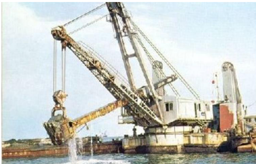
Figura 2.2 - Escavadeiras frontais ou retroescavadeiras
