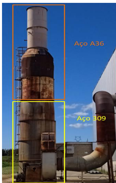
Figura 10 - Composição do lavador de gás
