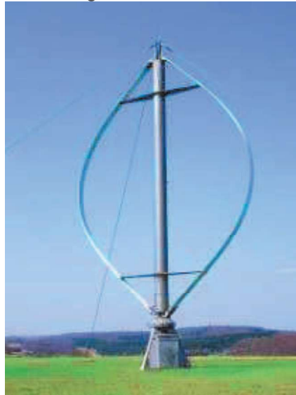
Figura 4 - Aerogerador com rotor de eixo vertical
