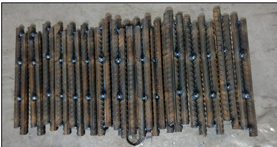
Figura 25 - Vergalhões marcados para iniciar o processo de soldagem
