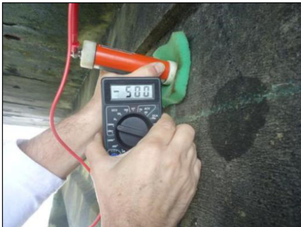
Figura 20 - Registro da medição realizada no ensaio de Potencial de Corrosão
