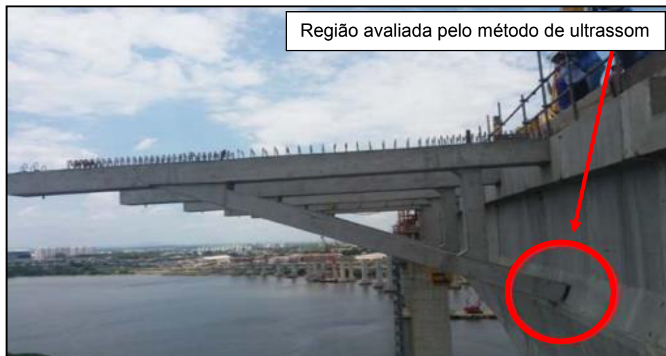
Figura 2 - Local do ensaio de ultrassom
