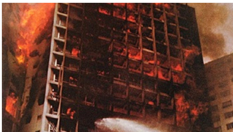
Figura 1.2 - Incêndio no edifício Joelma em 1974
