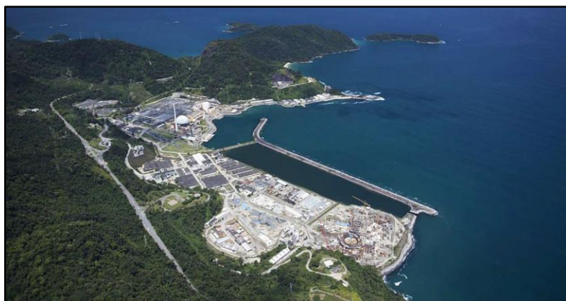
Figura 9 - Vista aérea do Quebra-Mar que protege a planta industrial da Central Nuclear Almirante Álvaro Alberto, Angra dos Reis, Rio de Janeiro. Fonte: Eletro-nuclear (acessado em: 13/02/2025).
