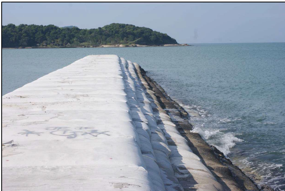
Figura 12 - Espigão Guia-Corrente construído com geotêxteis (geobags) para interromper o transporte de sedimentos, fixar a embocadura de um canal e fornecer acesso à uma marina em Armação de Búzios, RJ. Fonte: Foto de Eduardo Bulhões, 2015.
