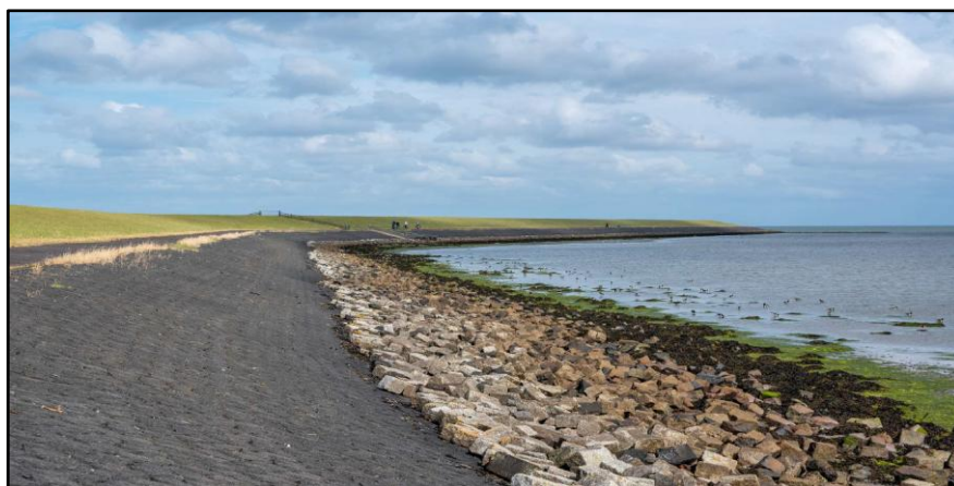
Figura 11 - Dique coberto por grama, concreto e protegido por enrocamento na Holanda. Fonte: Kobus van Leer (2019).
