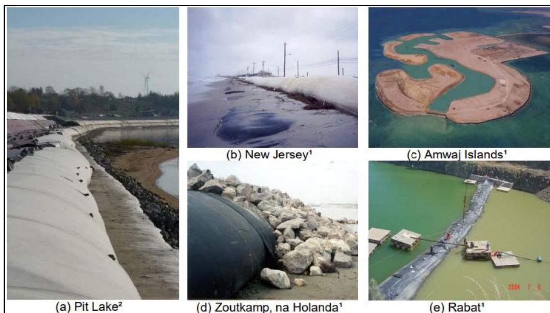
Figura 16 – A) Pit Lake, na Alemanha, um projeto de estabilização da margem de um lago; Figura B) New Jersey, Estados Unidos, a estabilização de um litoral com forte processo de erosão costeira; C) Amwaj Islands, Bahrein, foram utilizados 30 km de FTT de 2,6 m de altura na primeira fase do projeto e, em seguida, outra FTT completando uma altura de 3,6 m para formação de um dique para as ilhas artificiais do país; D) Zoutkamp, na Holanda, um projeto de estabilização de taludes em barragem; E) Rabat, Marrocos, 3 FTT de 65 m de comprimento, 15 m de circunferência e 3 m de altura, foram a solução proposta para a Barragem de Sidi Mohamed Ben Abdellah. Fonte: Koffler et al. (2008) e Wilke et al. (2015a)
