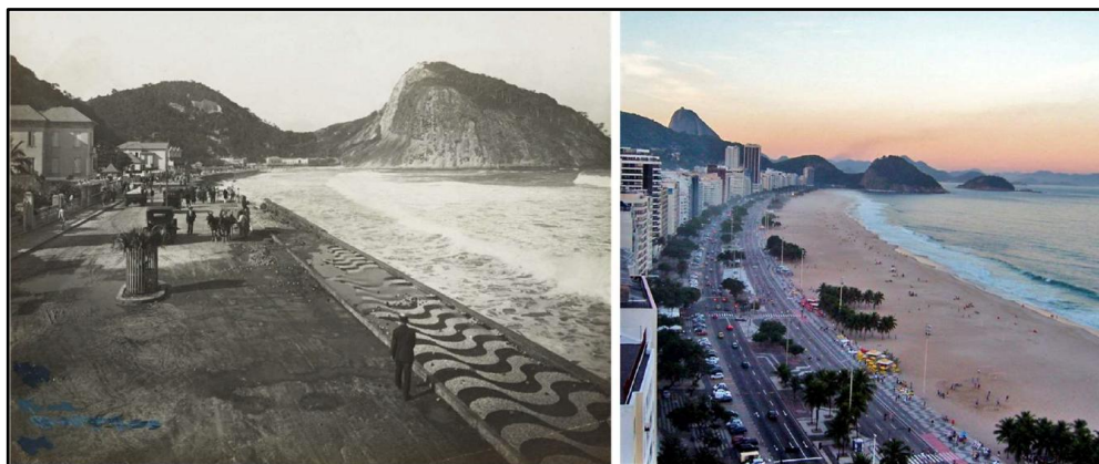
Figura 13 - Comparativo da Praia de Copacabana antes e depois do projeto de alimentação artificial. À esquerda, registro fotográfico de evento extremo com ondas de tempestade que destruíram o calçadão (Leme, década de 1920). À direita, vista panorâmica da praia após a execução da obra, em 2006. Fontes: à esquerda, Fundação Biblioteca Nacional; à direita, Renata Rocha (Wikimedia Commons).
