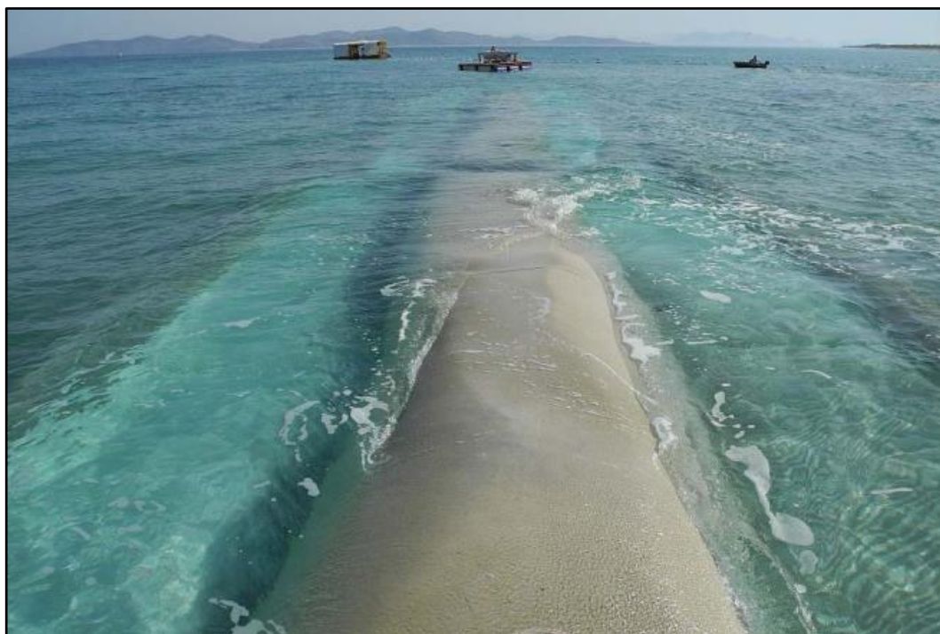
Figura 14 – Forma têxtil tubular como estrutura de quebra-mar. Fonte: Wilke et al. (2015b).
