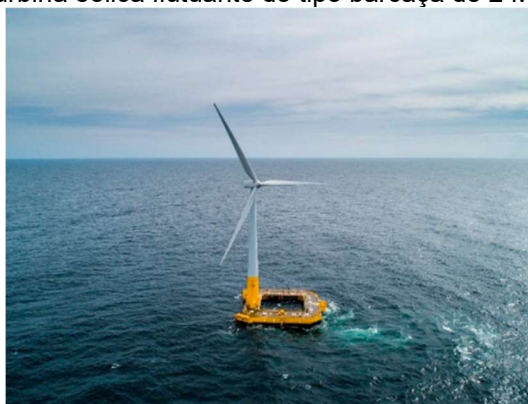
Figura 6. Turbina eólica flutuante do tipo barcaça de 2 MW Floatgen.
