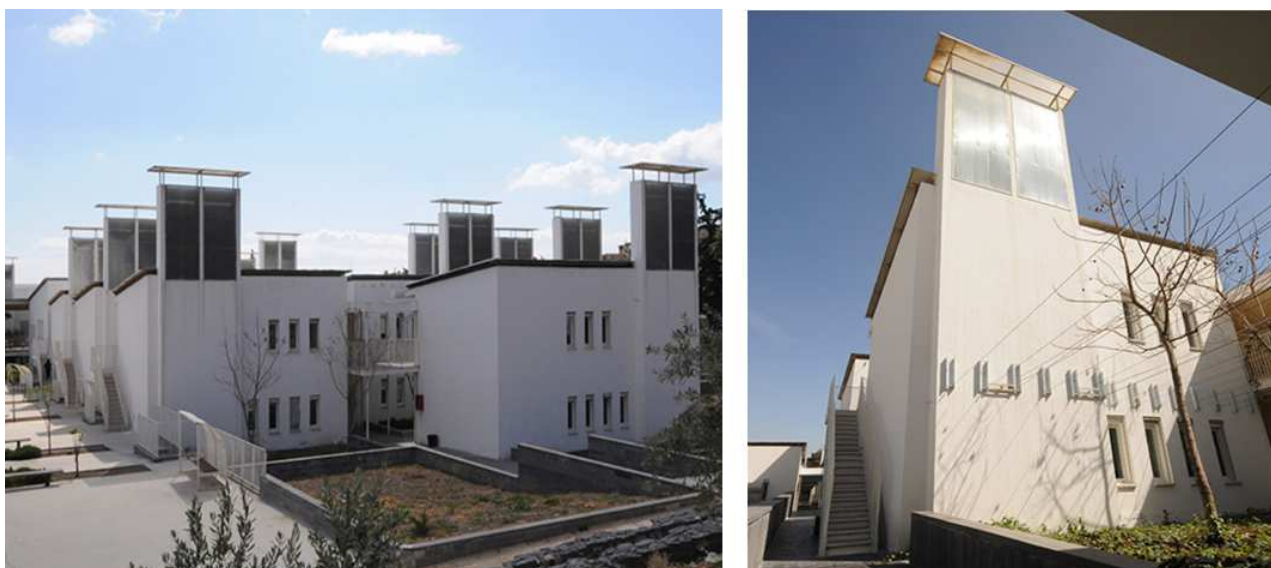
Figura 2.6. Vista das chaminés solares da escola Lycée Français Charles De Gaulle – Síria (Fonte: Prêmio Aga Khan de Arquitetura ciclo 2011-2013).
