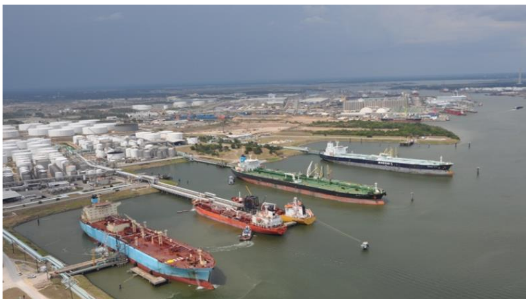
Figura 2.2 - Fingers piers de grãos líquidos localizados no canal de Houston. (Fonte: http://www.lanier-engineers.com/projects/marine-liquid-terminals/page2.html ).
