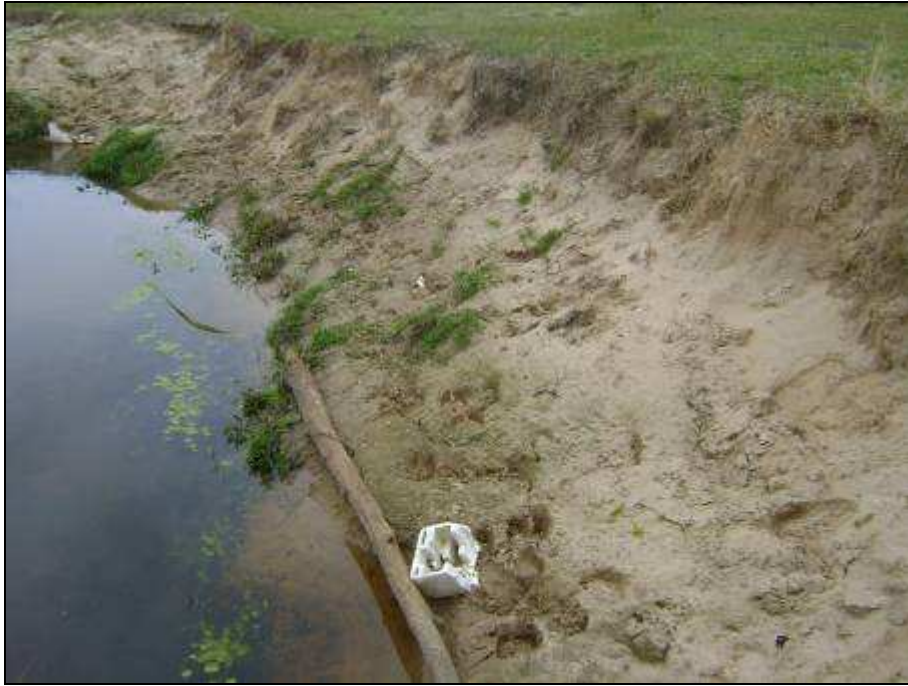
Margens do arroio Vieira.
