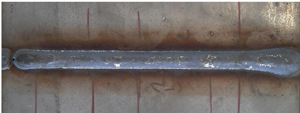
Figura 4745 – Aspecto visual do cordão de solda
