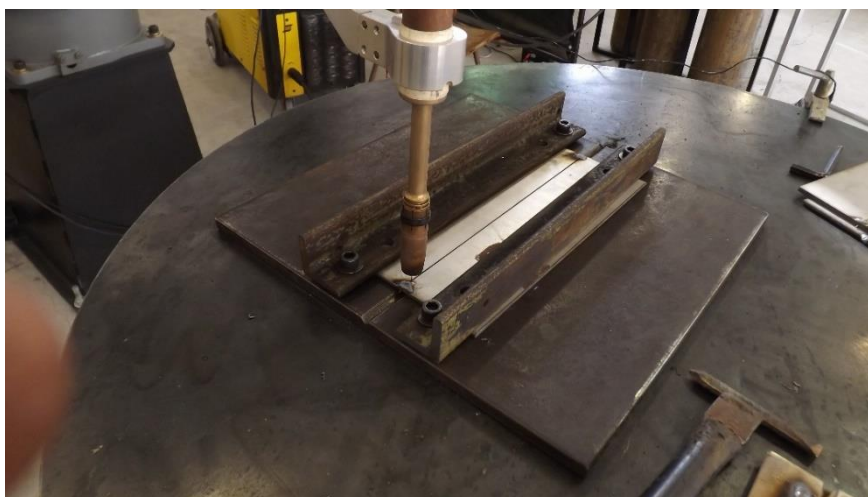
Figura 35 – Preparação para soldagem
