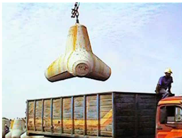
Foto 3.2 – Transporte dos tetrápodes de 8 toneladas aos molhes da Barra (Guimarães et al., 2003).
