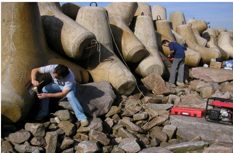
Foto 3.15 – Extração das amostras de concreto no ponto MLOI aos 9,5 anos de idade.
