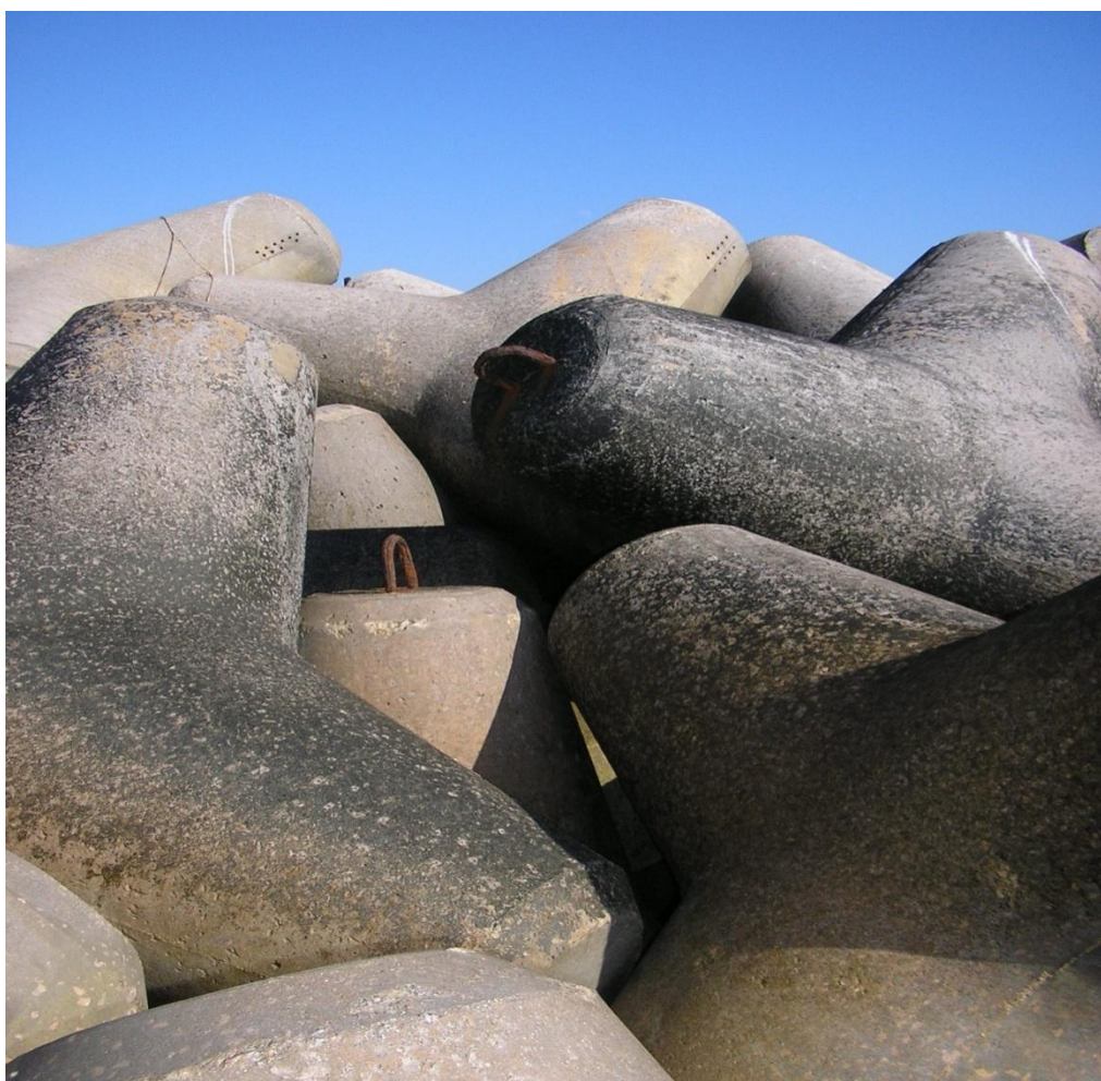
Foto 3.10 – Os dois tetrápodes que compõem o ponto MLLS aos 9,5 anos de idade - furos referentes à extração de material na idade de 5 anos.
