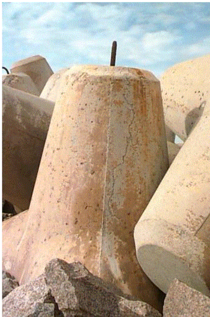
Foto 3.3 – Tetrápodes com bolhas de ar visíveis a olho nu (Guimarães et al., 2003).
