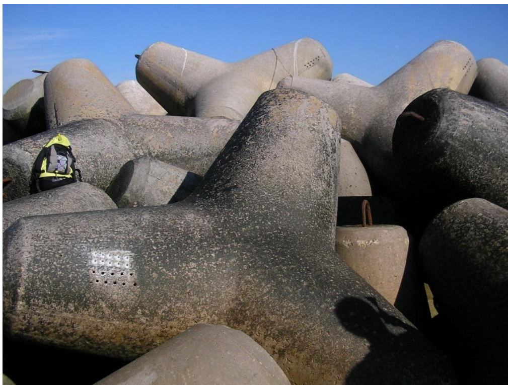
Foto 3.12 – Um dos tetrápodes que compõe o ponto MLLM - 20 furos referentes à extração de material aos 5 e aos 9,5 anos de idade. Mais ao alto tetrápodes com furos do ponto MLLS
